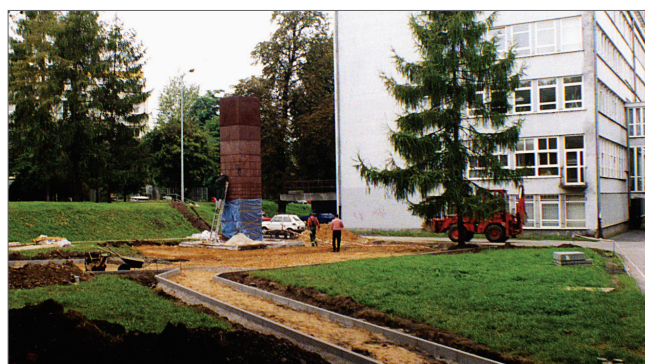
Wyrównywanie terenu pod zagospodarowanie zieleni
