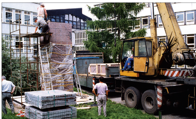
Montaż elementów pomnika
